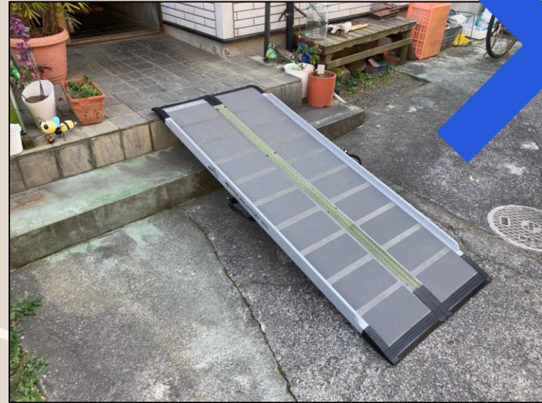
持ち運びを必要とする屋外用長尺スロープ
